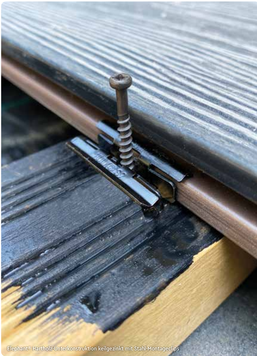
Elephant® keilgezinkte Hartholz-Unterkonstruktion mit DuoWood-Clips
